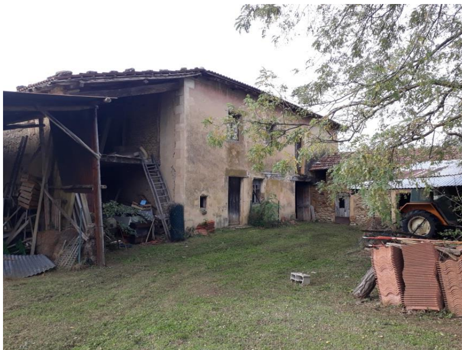
Bâtiment n° 10 – 2 parties nord et sud
